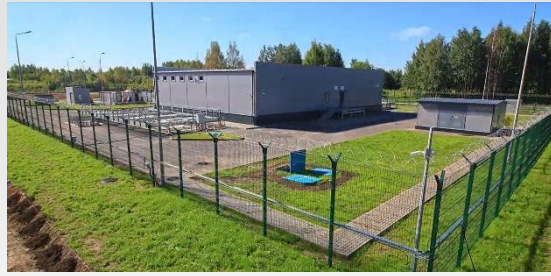
Проектирование и строительство ЦОД
