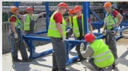
Строительство и монтаж
